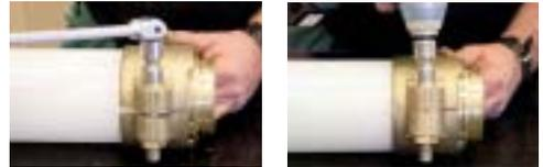
5.- Montar la tubería sobre el cuerpo Uponor PEX correspondiente.
