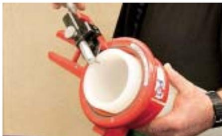
2.- Colocar el accesorio adaptador Uponor PEX grandes dimensiones bronce sobre la tubería.
