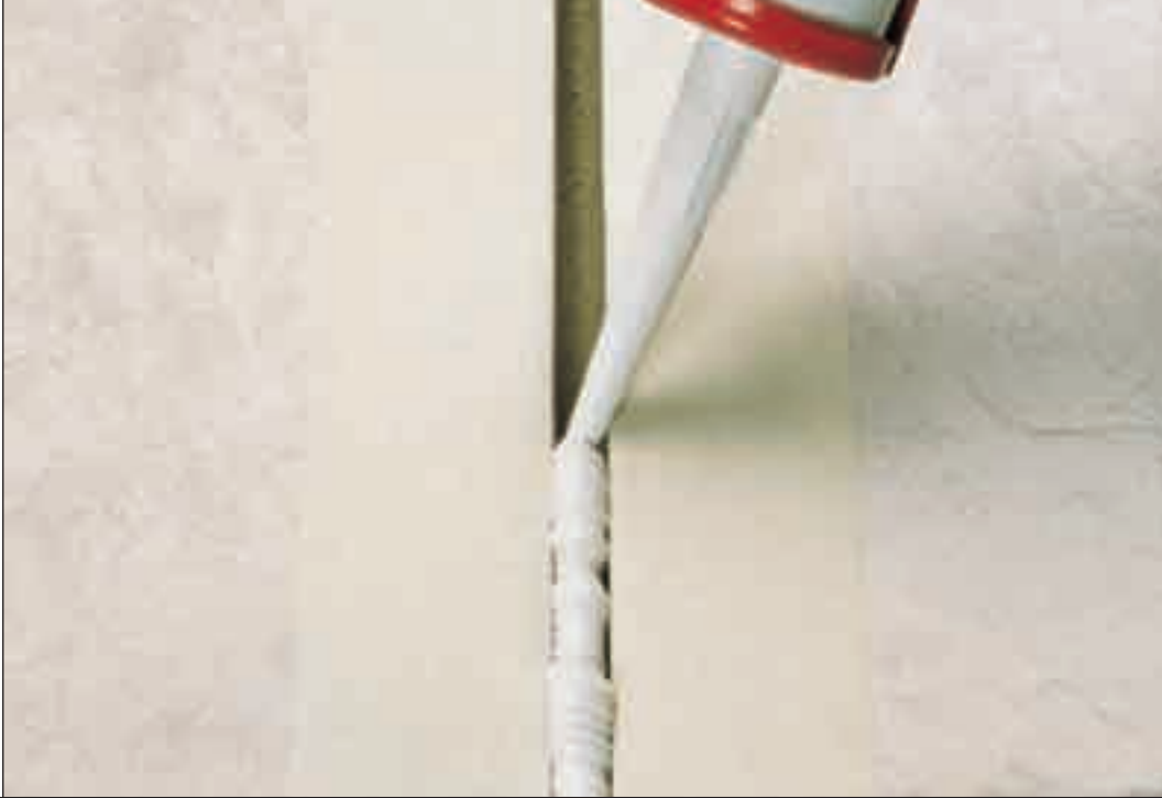
40 Aplicación del sellante s-502 . / Application of s-502 sealant.
