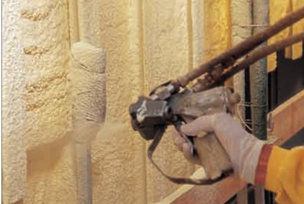
Proyección con pistola, por el método "airless". / Sprayed on using the airless system.
