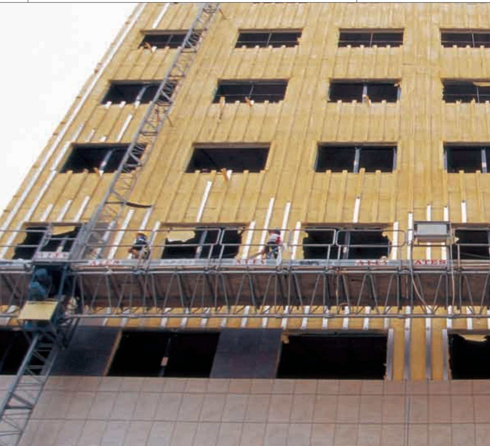
16 Sistema FV con anclaje oculto. / FV System with hidden anchoring.
