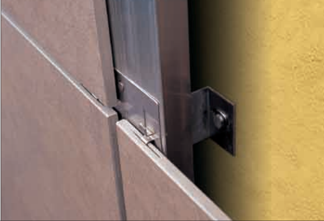
16 Sistema FV con anclaje oculto. / FV System with hidden anchoring.
