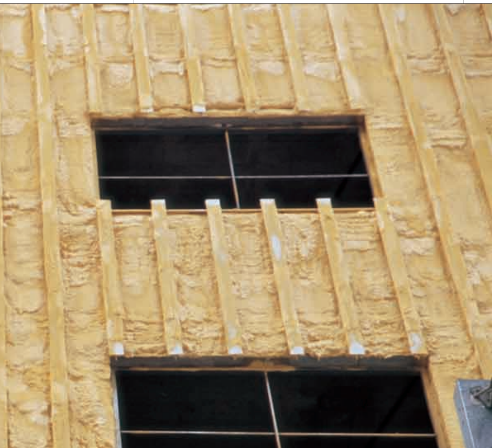
Proyección con pistola, por el método "airless". / Sprayed on using the airless system.
